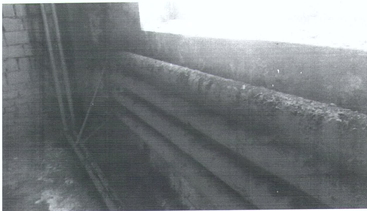
Фото № 8 (Состояние теплоприборов)
